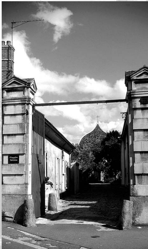
Entrée du monastère de la Visitation, faubourg Croncels, en 1999. Au fond, la chapelle. (Photo M. Toussaint).
