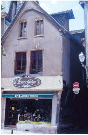
Vue de la façade rue Georges Clemenceau, avant restauration.
