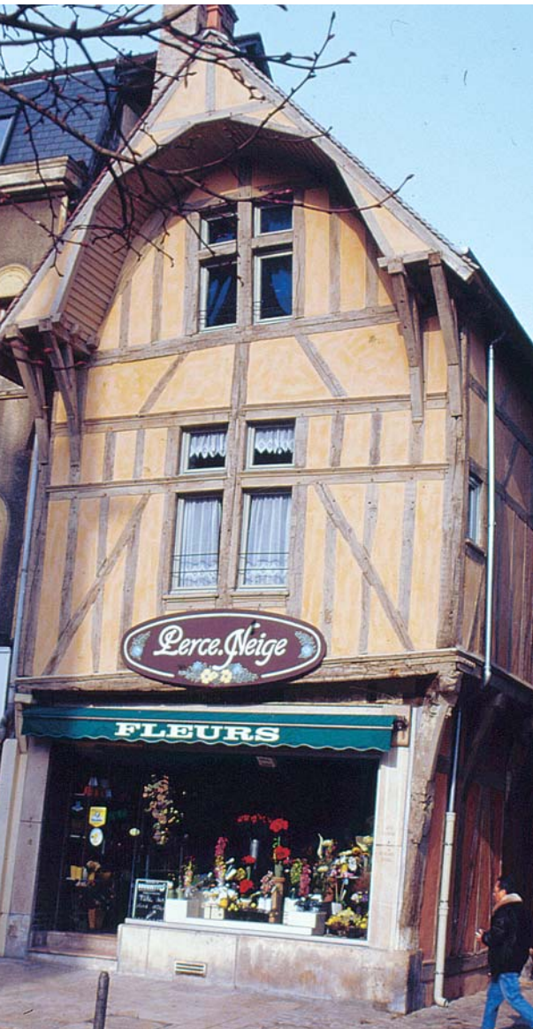
Immeuble situé à l'angle de deux rues dont une semi-piétonne, parmi les plus belles du corps du Bouchon, située face à l'église Saint-Urbain. Vue après restauration.
