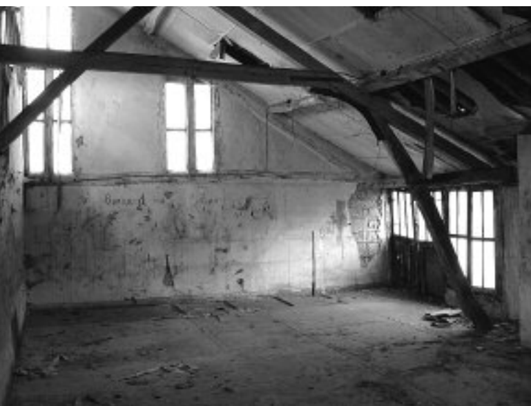
Atelier de la rue Brunneval (3 e étage).
