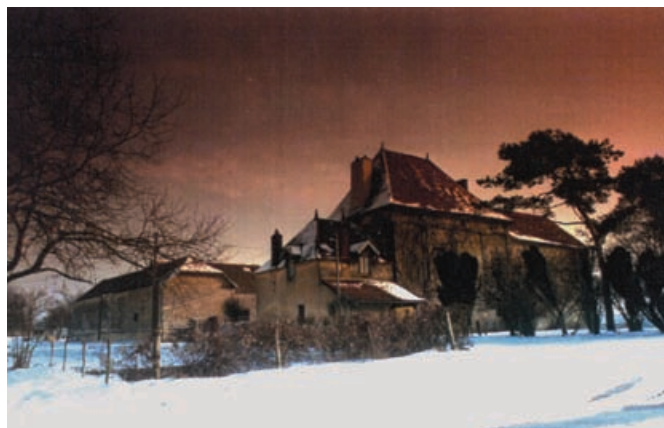
Ferme forte de Malassise, commune de Balnot, février 1991 (cliché Alain Hugerot).
