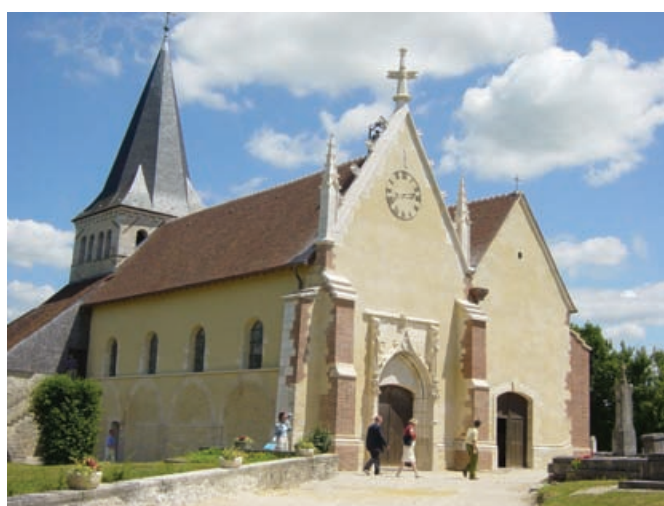
Vue générale avant travaux.
